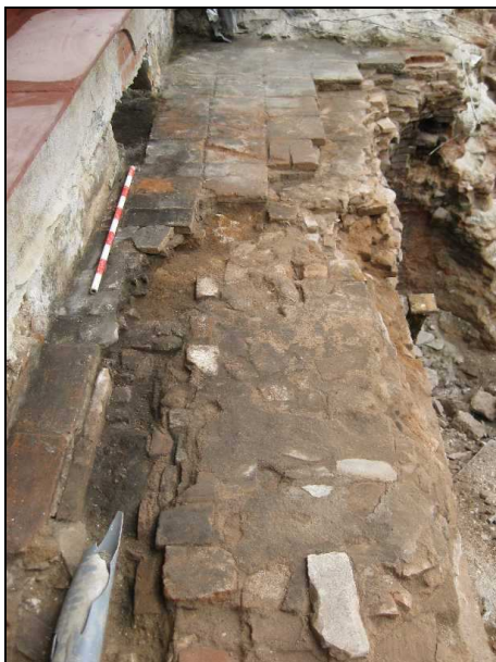
FOTO 35. Paviment i la seva preparació UE 336 relacionats amb una fogaina que alimentava unes calderes d'una màquina de vapor. Sector 2, fase segona
