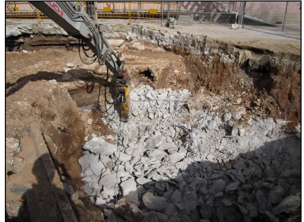
FOTO 34. Demolició de la base de formigó per a una grua, presumiblement de l'any 1994 (retall UE 314). Sector 2, fase tercera
